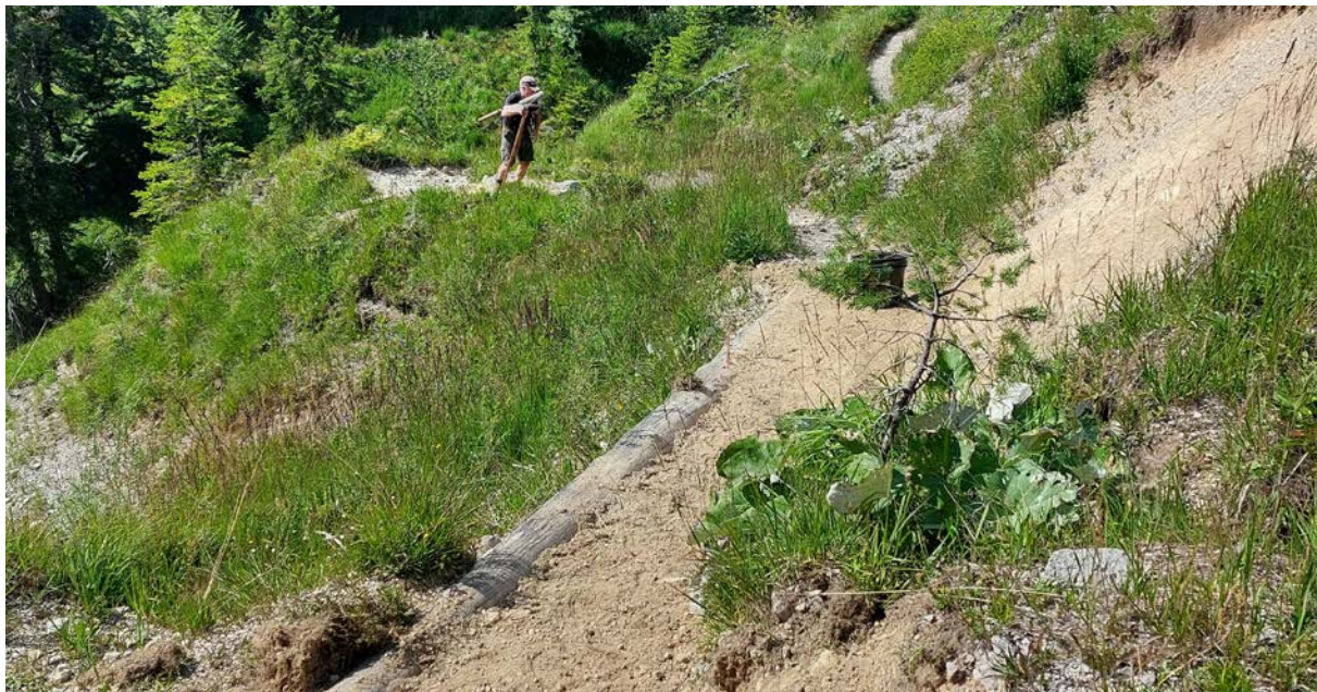
Beim Ausbessern des Wegs unterhalb der Staffelalm
